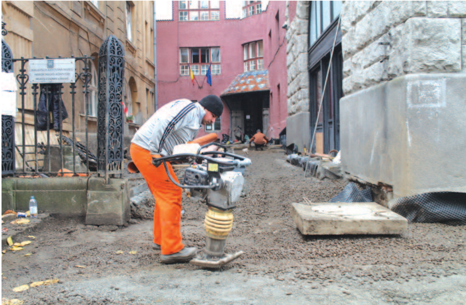
A Kultúrpalota felújításának külső munkálatait tavaly ősszel végezték
